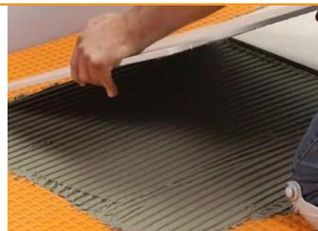
**6** Обязательно проверяется качество нанесения клея на мембрану. Для этого отгибается угол уложенной мембраны и проверяется, вся ли площадь листа покрыта клеем. Если клея недостаточно, лист необходимо снять и добавить еще слой клея на основание. Затем снова раскатать и уплотнить лист.
