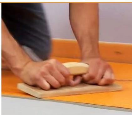
**5** Поверх клея раскатывается лист мембраны и прочно прижимается к полу деревянной теркой. При укладке больших площадей используется ролик, нагружаемый мешками с плиточным клеем.
